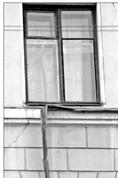
Дом треснул не вдоль, а поперек, карниз тоже отвалился
