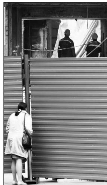
Прохожие любопытствуют: зачем сносят вестибюль?
