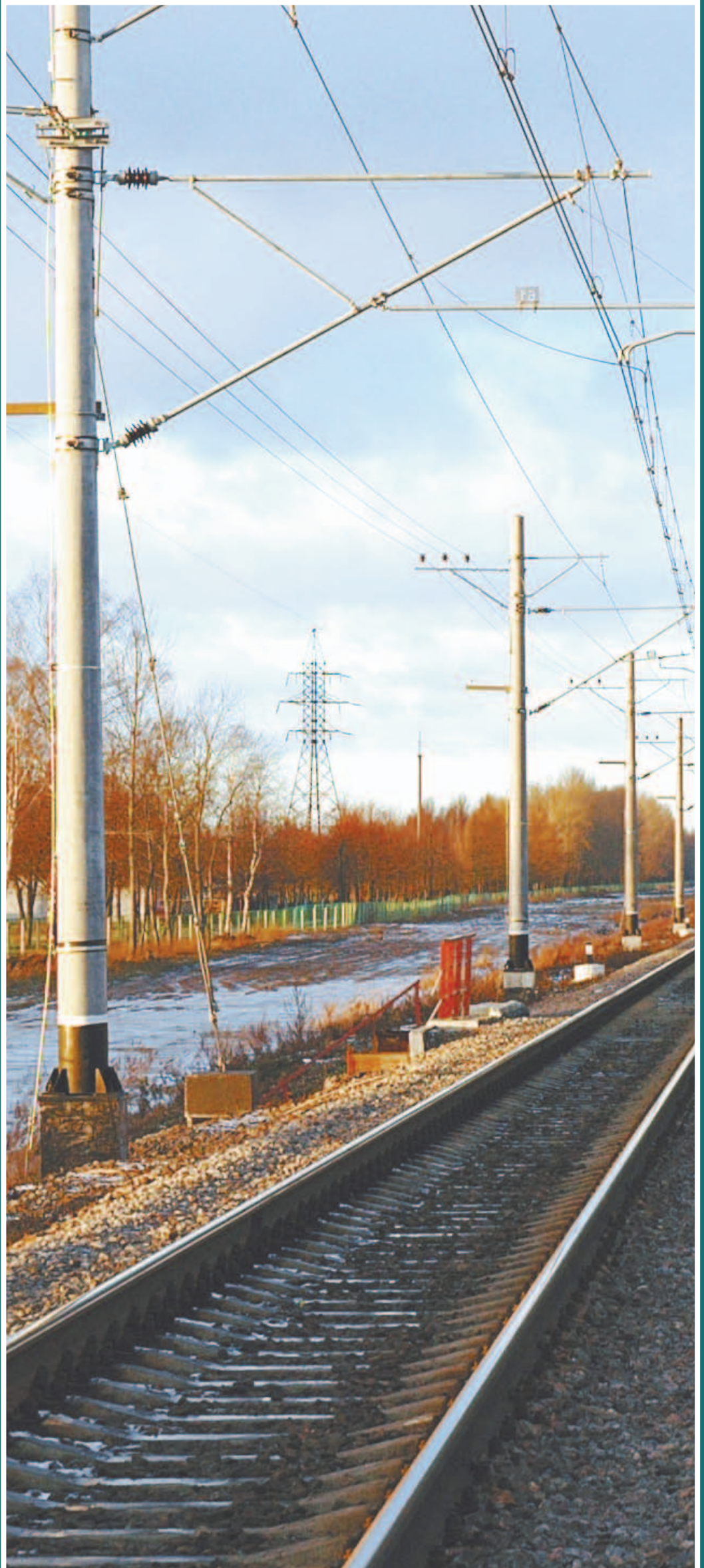
Контактная сеть КС-200-06 для скорости движения 200 км/ч на перегоне Саблино - Тосно Октябрьской железной дороги
