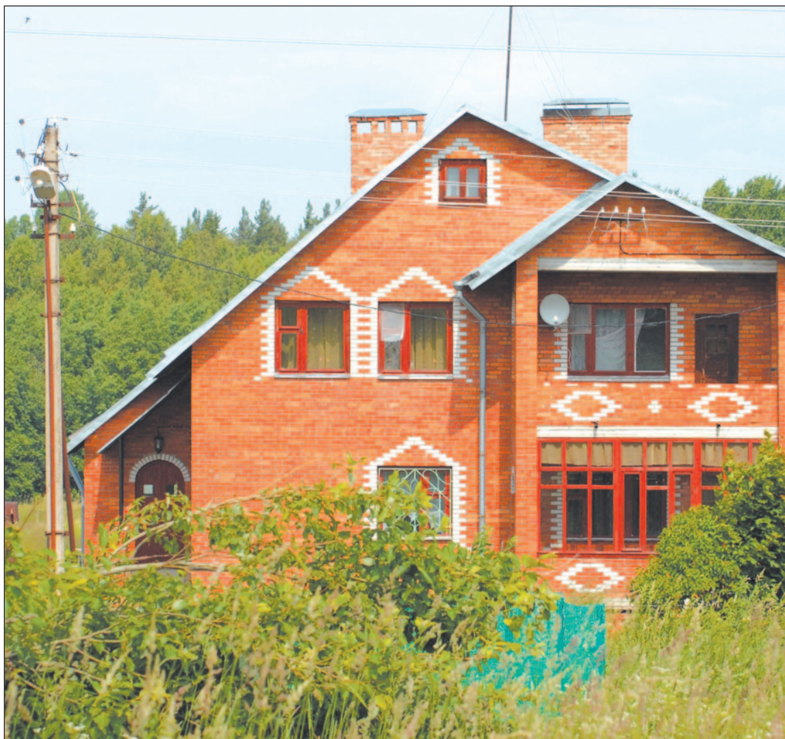
Энергоснабжение дома бизнесмена должно было быть прекращено еще два года назад. Но опоры ЛЭП и ныне там
