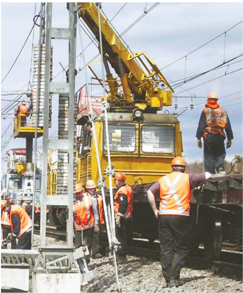
Монтаж опытных участков контактной сети для скорости движения 250 км/ч на участке Калашниково - Лихославль Октябрьской железной дороги
