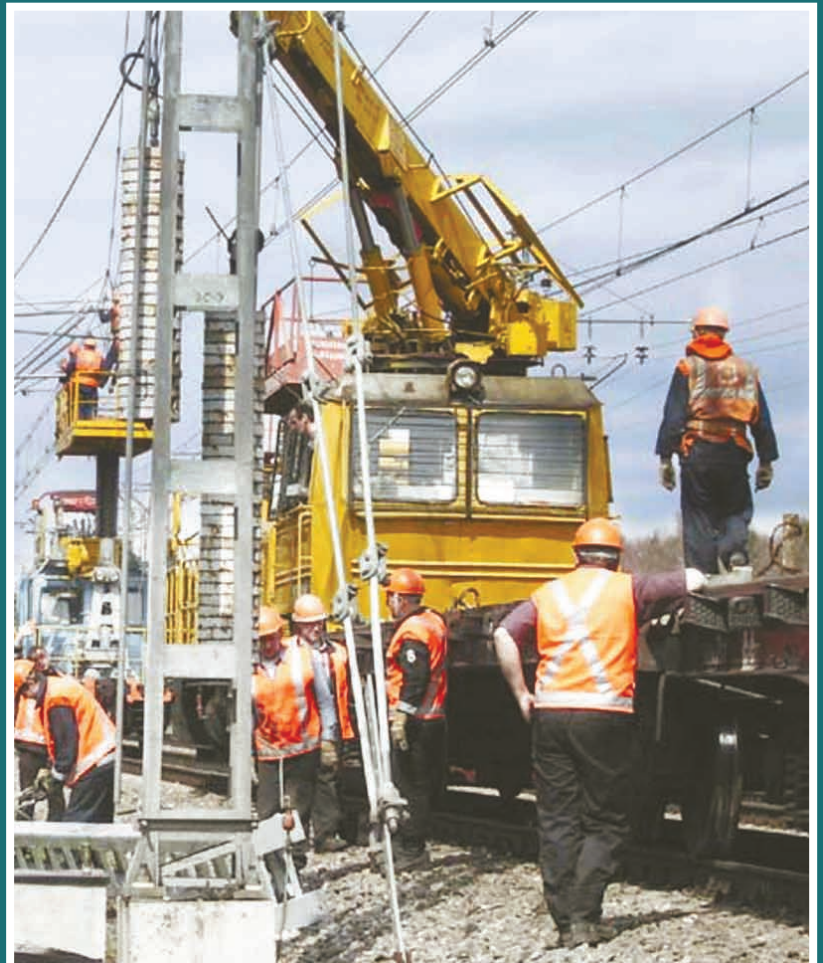
Монтаж опытных участков контактной сети для скорости движения 250 км/ч на участке Калашниково - Лихославль Октябрьской железной дороги
