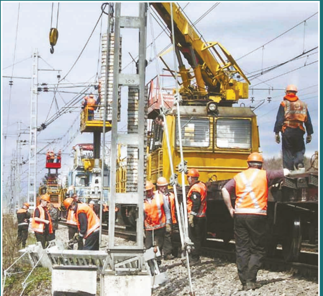
Монтаж опытных участков контактной сети для скорости движения 250 км/ч на участке Калашниково - Лихославль Октябрьской железной дороги
