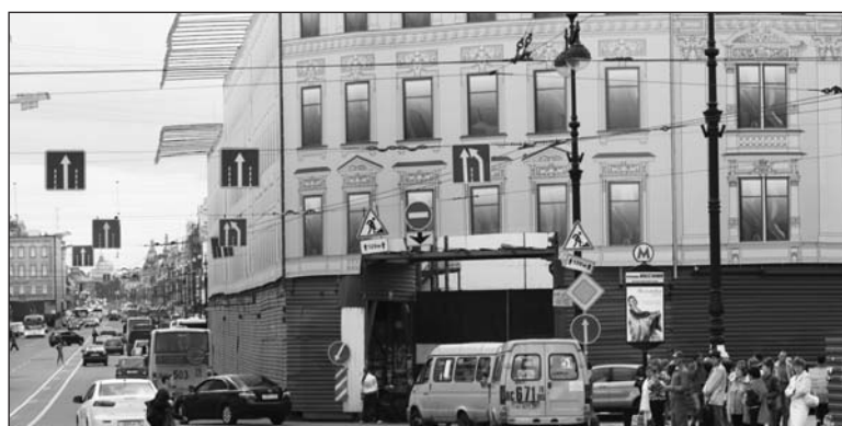
Строительное ограждение на углу Невского и улицы Восстания не красит город и давно мешает проезжающим
