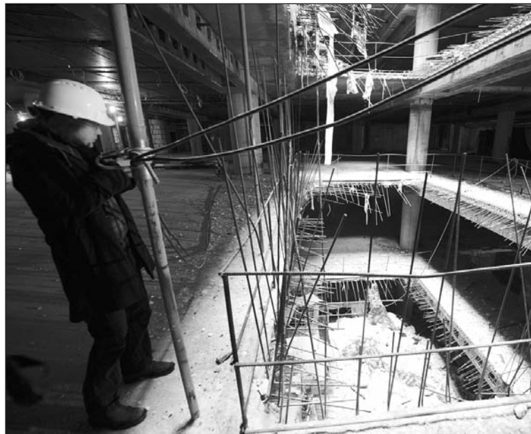
Стройка идет полным ходом
