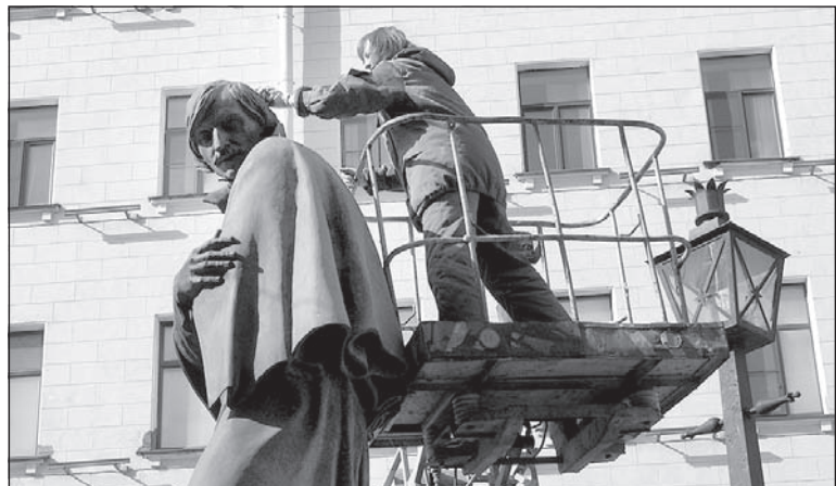
В Петербурге полным ходом идут реставрационные работы
