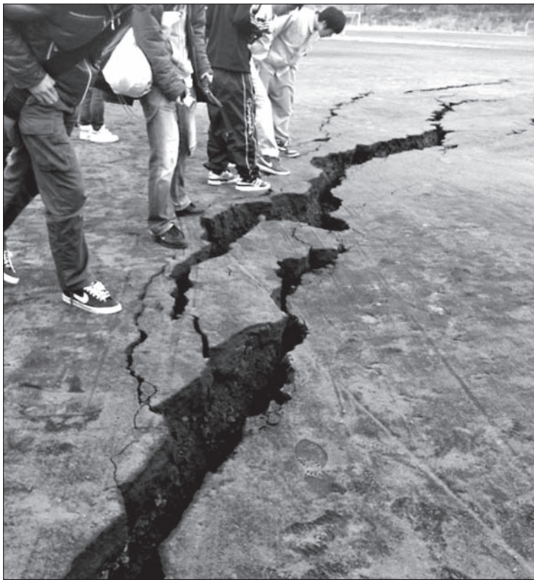
Провалиться сквозь землю можно в прямом смысле
