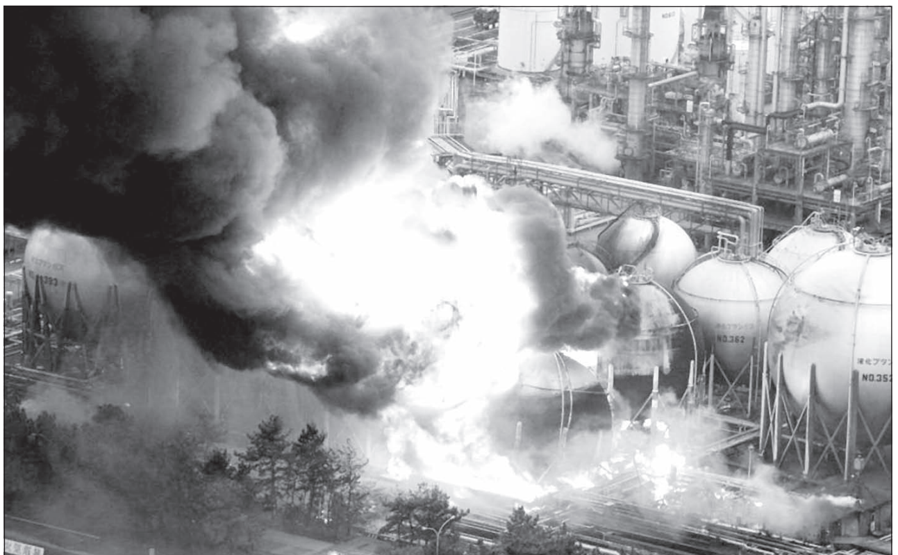
После землетрясения начались пожары на промышленных объектах и в жилых домах
