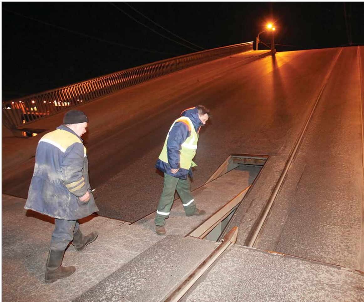
Рабочие бригады контролируют стыковку частей моста
